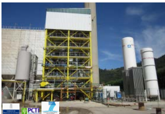
Figura 5. izq) Planta piloto de 1.7 MW t , en La Pereda; dcha) Resultados experimentales con eficacias de captura mayores del 90%.
